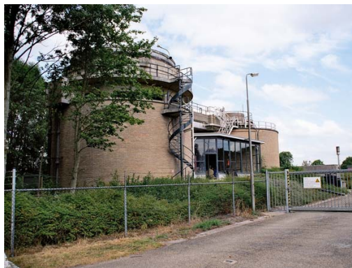
Rioolwaterzuiveringsinstallatie bij De Netelhorst
