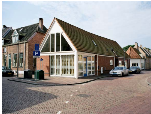
Recente vormgeving nabij het Marktplaatsplein
