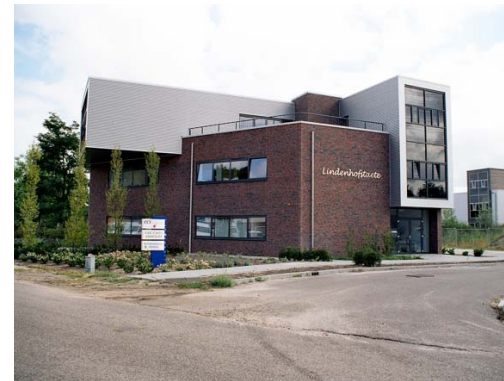
Kantoorgebouw aan de oostzijde van de Populierenlaan
