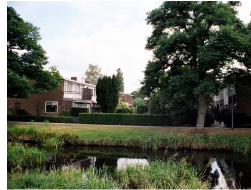
Achtergevel naar het parkje tussen Vijverstraat en Beekstraat
