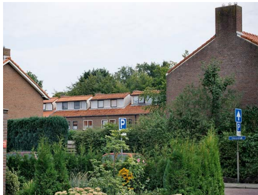
Zicht op de dakopbouwen van de achtergevels
