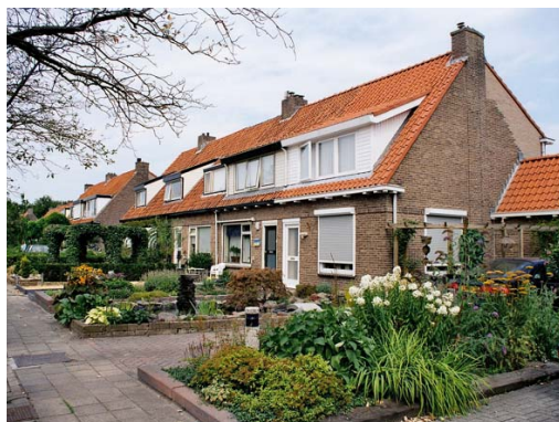
Blokken (met uitbouwen en dakkapellen) aan de Hezenbergerweg
