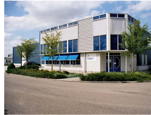
Kantoorgebouw aan de Netelhorst
