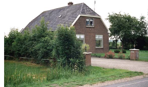
Woning uit de eerste helft van de twintigste eeuw (Oostersedijk)
