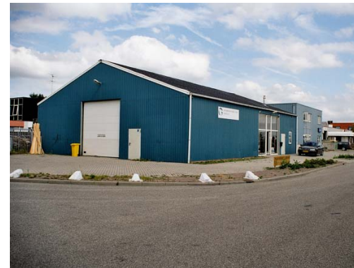
Loods aan de Netelhorst
