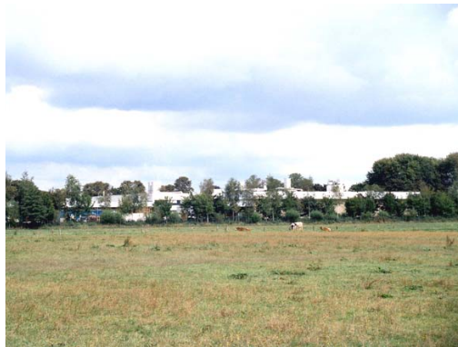
Zicht op het industriële gebouw vanaf de Stadslaan
