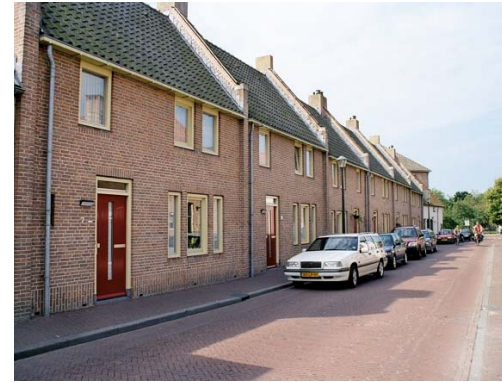
Nieuwbouwwoningen in de Koestraat
