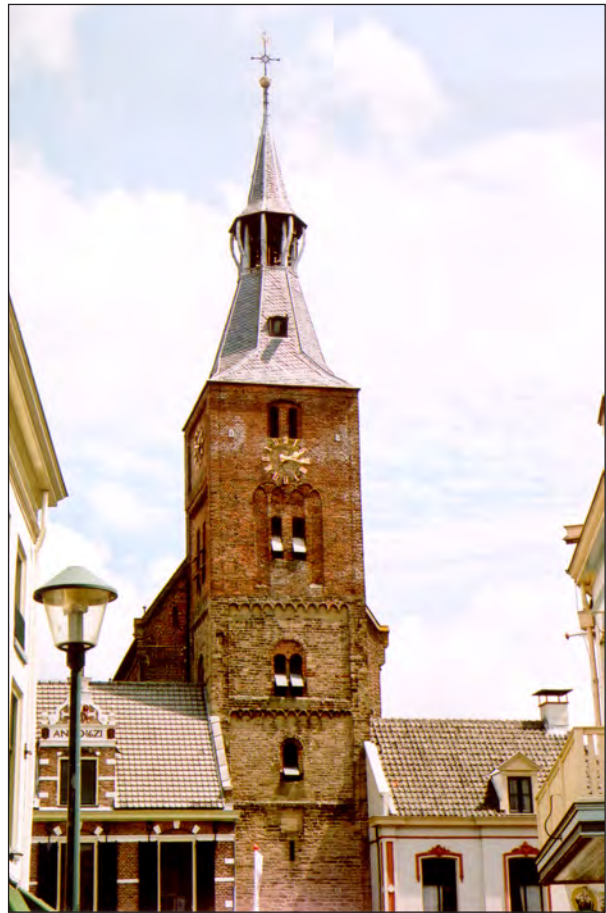
Duidelijk is de overgang te zien tussen de tufstenen bekleding van de oude onderkant en de bouw in bakstenen van de jongere bovenkant.
