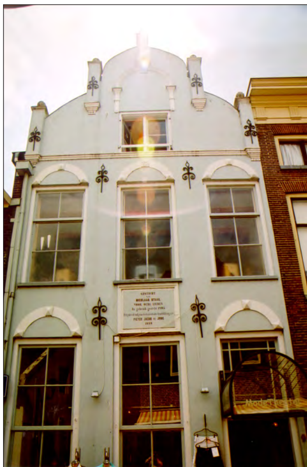
Kerkstraat 9 "Het Staalgesticht".
