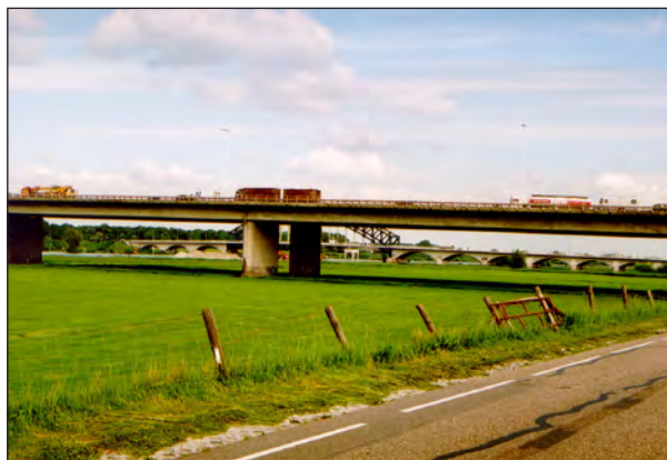
De uiterwaarden en de Nieuwe IJsselbrug, mogelijk heeft Katen hier ooit eens gelegen.
