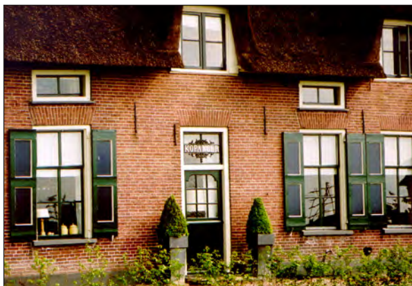
Voorgevel van Kopanger.
